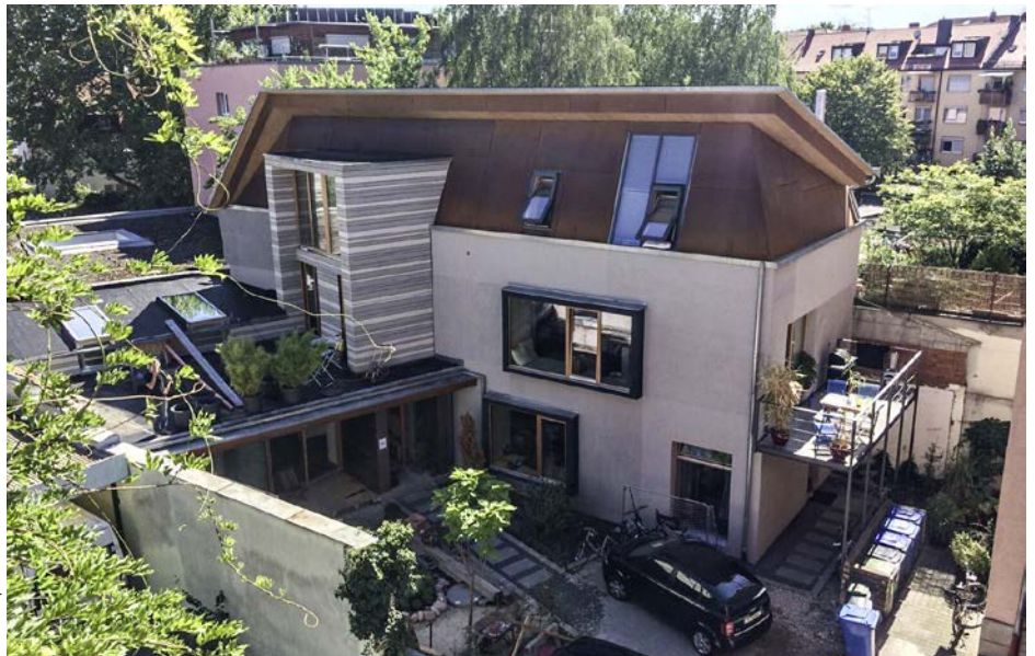
Dieses Wohnhaus in Nürnberg wurde 1890 erbaut. Energietechnisch ist es nun nahezu auf KfW-40-Standard.
